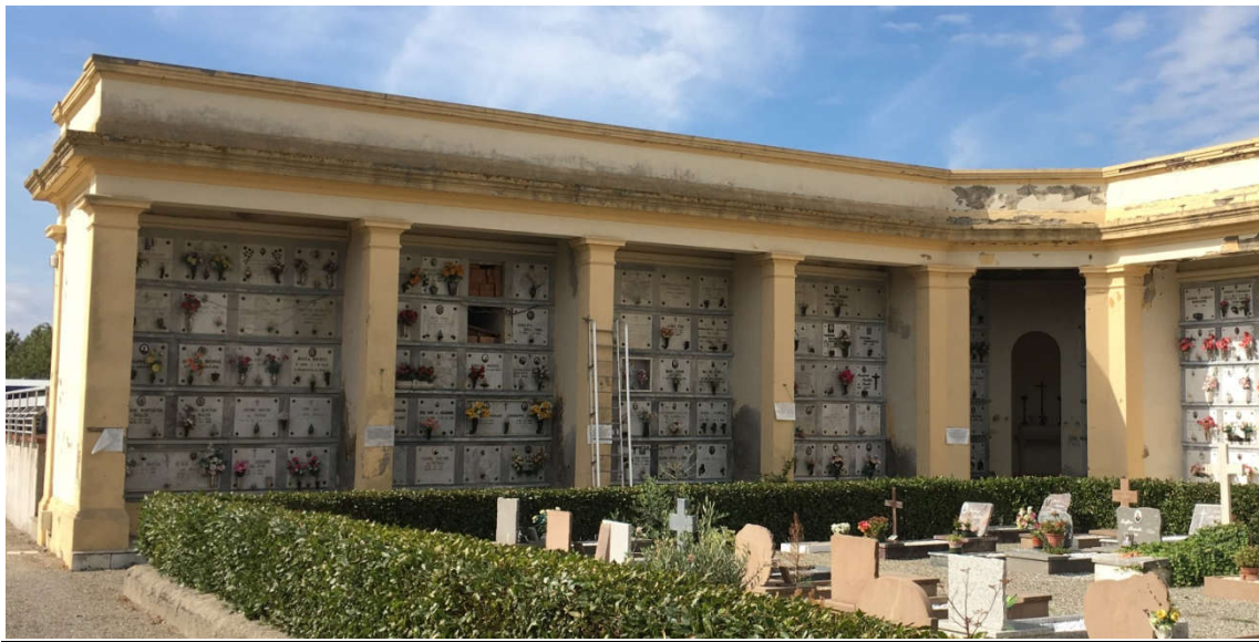
Vista frontale del lotto di intervento
