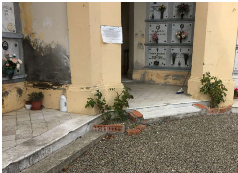
Pavimentazione delle logge
