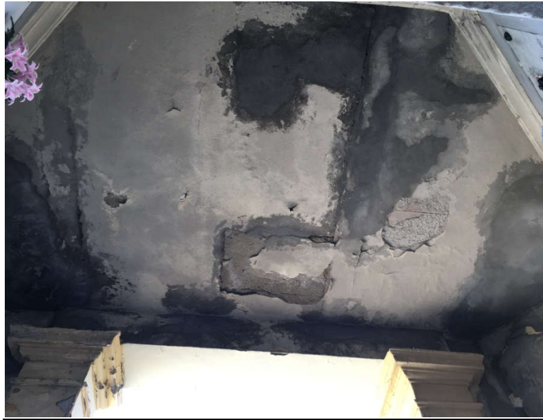
Soffitto della loggia
