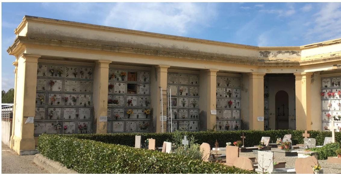
Vista frontale del lotto di intervento
