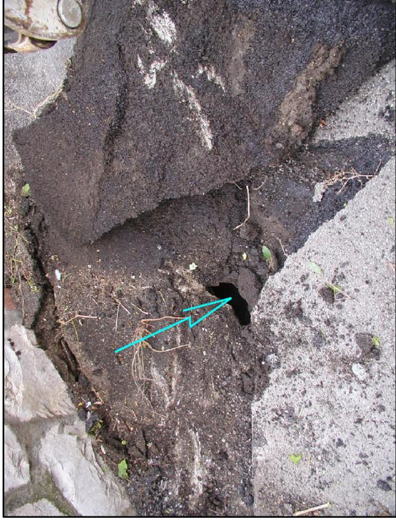
Foto 9-10: (febbraio2003) lesione in corrispondenza del muro successivamente consolidato e fessura rilevata alla base del muro stesso
