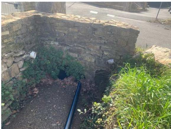
Dettaglio dell'imbocco del tombamento (già piuttosto interrato ed ostruito)
